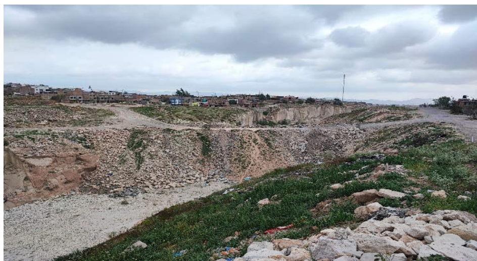
FIGURA N°03: SE OBSERVA DIQUE PARA PASE VEHICULAR EN LA QUEBRADA ESTANQUILLO A LA LATURA DE PUENTE PACHAS AGUAS ABAJO EVITANDO EL PASO DEL AGUA Y PONIENDO EN PELIGRO A LA POBLACION DE LA MARGEN DERECHA
