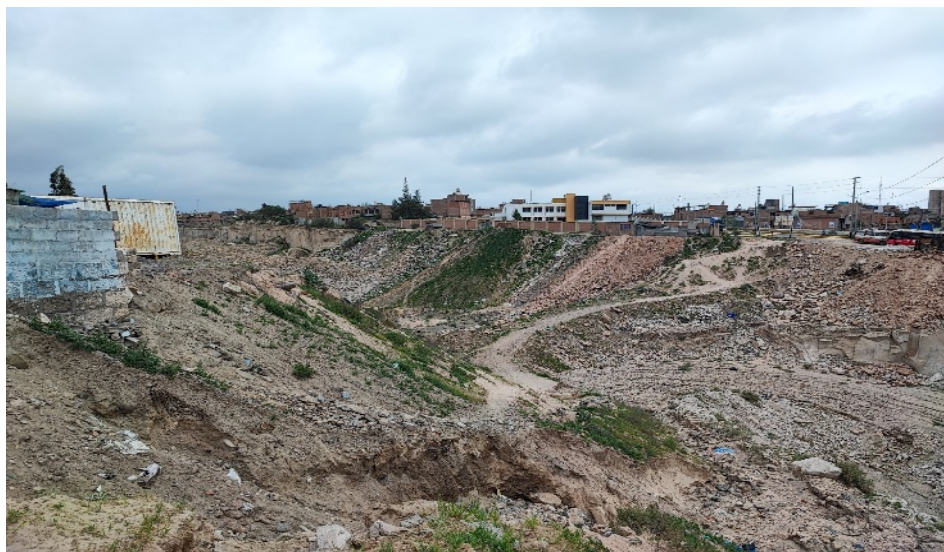
FIGURA N°02: TRAMO CRÍTICO COLMATADO CON DIQUE EN EL CAUCE, EROSIONADO POR LA AVENIDA OCASIONADA EN EL MES DE FEBRERO EN LA CIUDAD DE AREQUIPA
